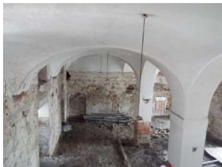
Intervenții în structura construcției vizibile după îndepărtarea tencuielilor.
