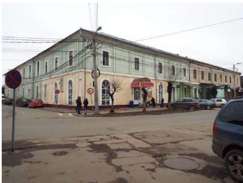
Clădirea principală a fostei Fabrici de Păruri „Părplast”, fațadele sudice și vestice
