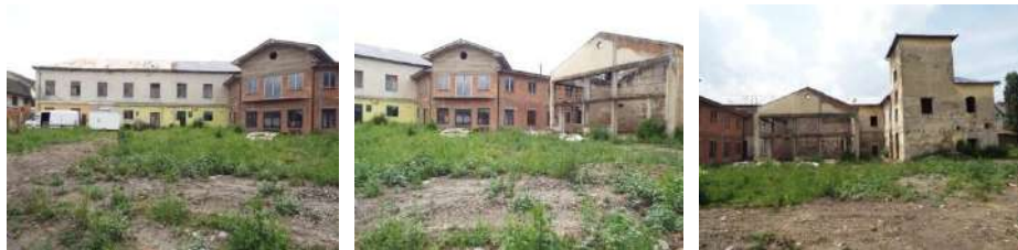
Clădirea principală a fostei Fabrici de Păruri „Părplast”, fațadele nordice și estice
