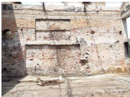
Intervenții în structura construcției vizibile după îndepărtarea tencuielilor.
