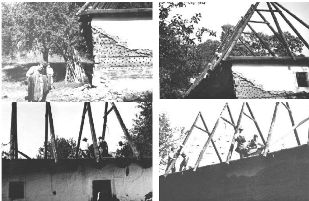
Figurile 12, 13, 14, 15. Începerea demontării casei, a acoperișului, a tencuielii (fotografii din colecția Muzeului Național Bran).
