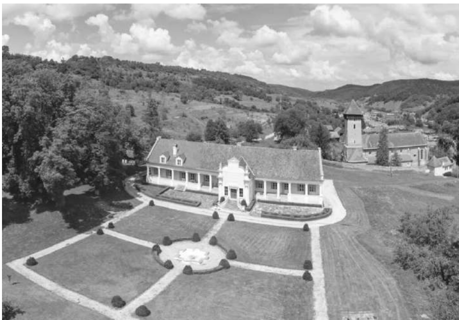
Fig. 5: Perspectivă exterioră a conacului și a grădinii Apafi din Mălâncrav. Sursă fotografică: www.romanian-romance.com/destination-item/apafi-manor/
