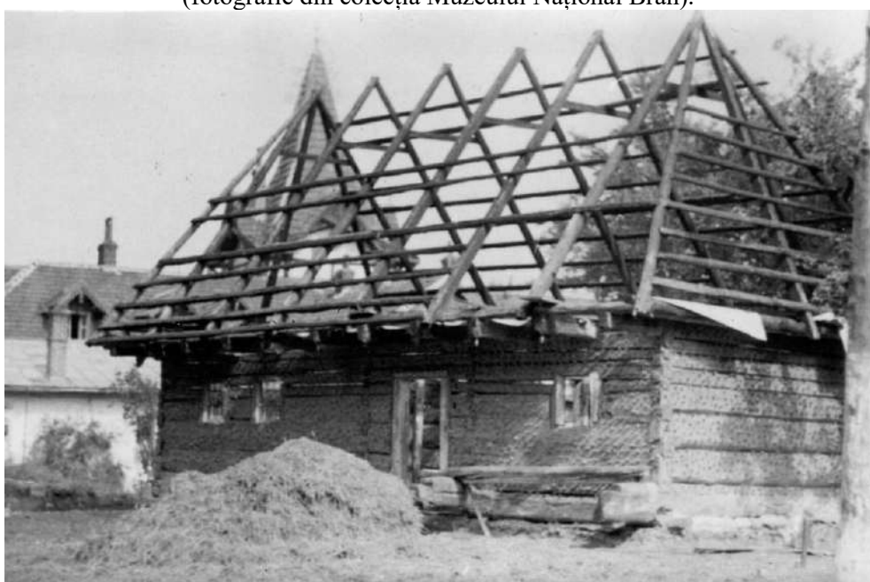
Fig. 20. Construcția după montarea pereților din lemn și parțial a elementelor din lemn ale acoperișului. Pregătirea plevei pentru tencuială (fotografie din colecția Muzeului Național Bran).
