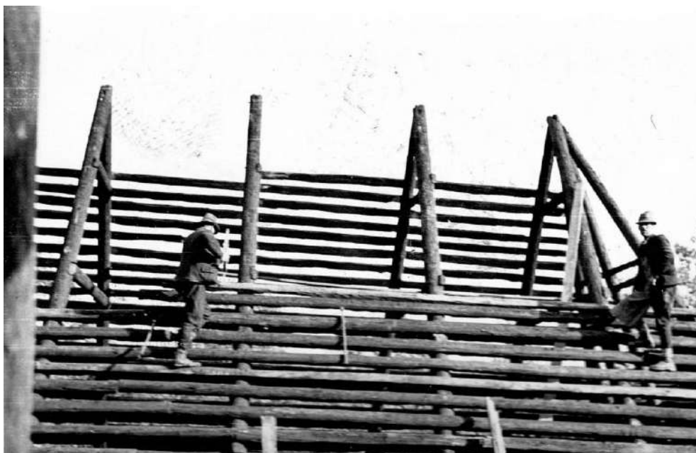
Fig. 19. Montarea acoperișului casei de colibași în Secția etnografică a muzeului (fotografie din colecția Muzeului Național Bran).
