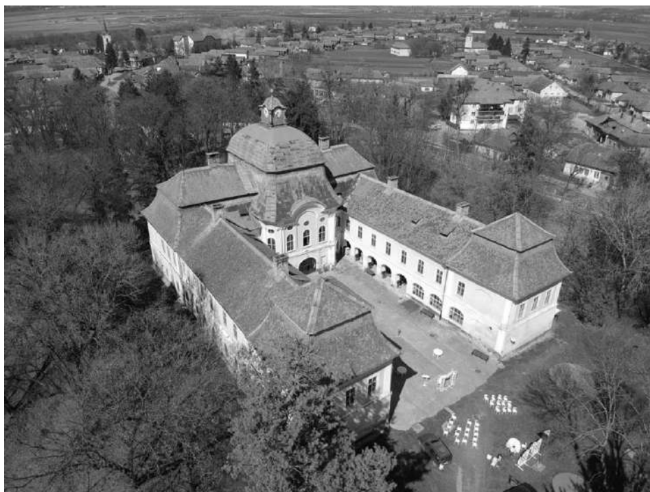
Fig. 1: Vedere aeriană a castelului Teleki și a parcului-grădină din Gornești. Sursă fotografie: https://planiada.ro/
