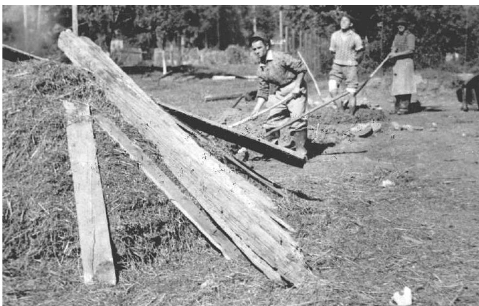
Fig. 22. Amestecarea lutului cu pleava, amestec necesar tencuirii casei de colibași (fotografie din colecția Muzeului Național Bran).
