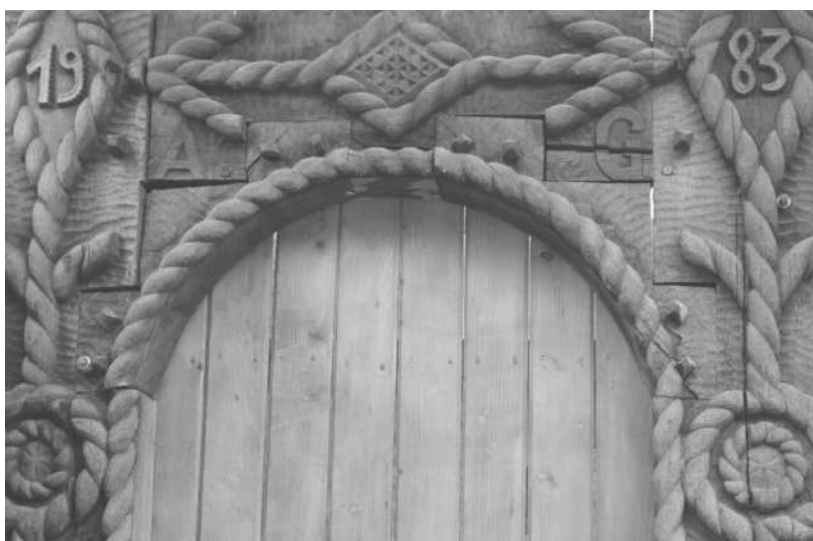
Fig. 11 –Detaliu, pragul de sus și chitușii porțiței cu inscripția datării și inițialele proprietarului
