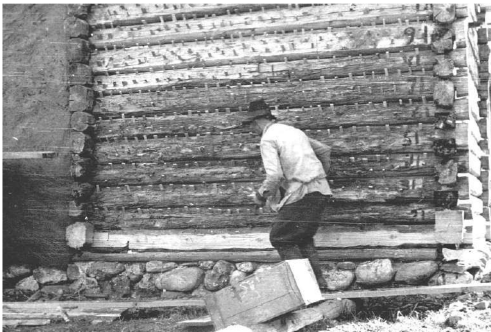
Fig. 21. Lucrările de montare a pereților casei, completarea „puricilor” rezultați din demontarea casei (fotografie din colecția Muzeului Național Bran).
