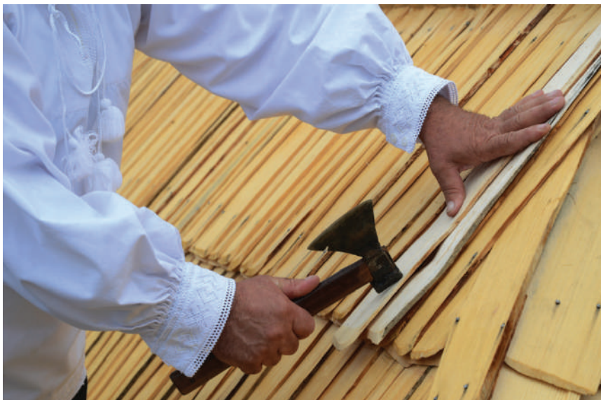
Meșterul Bledea Liviu drănițând acoperișul la o poartă Master Liviu Bledea shingling the roof of a wooden gate
