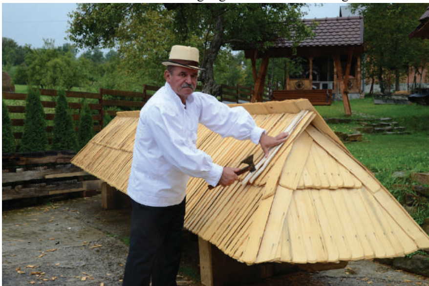
Meșterul Bledea Liviu drănițând acoperișul la o poartă Master Liviu Bledea shingling the roof of a wooden gate
