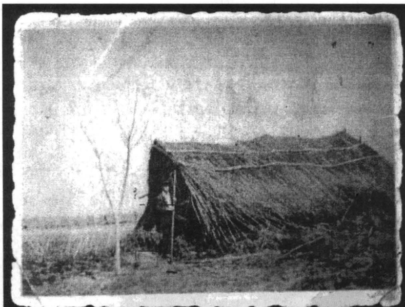
După inundația Prutului, la Frumușița (jud. Brăila), în 26 august 1955, din casa lui Vasile Binec, originar din Cărpiniș, nu a mai rămas decât acoperișul (Apud; V. Marineasa, D. Vighi, op. cit. )
