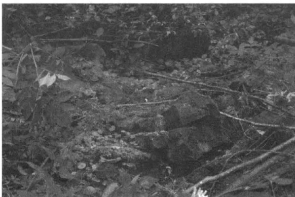
Foto 3- Fundația din piatră a vechilor băi
