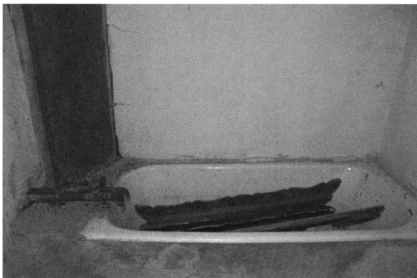
Foto 5- Interior, cadă de baie
