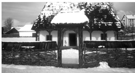
Fig. 149: Fotografie cu perspectiva frontală a porții din lemn de acces și a gardului care împrejmuiește limita de est a parcelei pe care se află clădirea studiată. Fotografia a fost luată din exteriorul parcelei, din stradă, la nivelul ochiului. Sursă fotografie: arhitect Cantoni Nicholas (2022).
