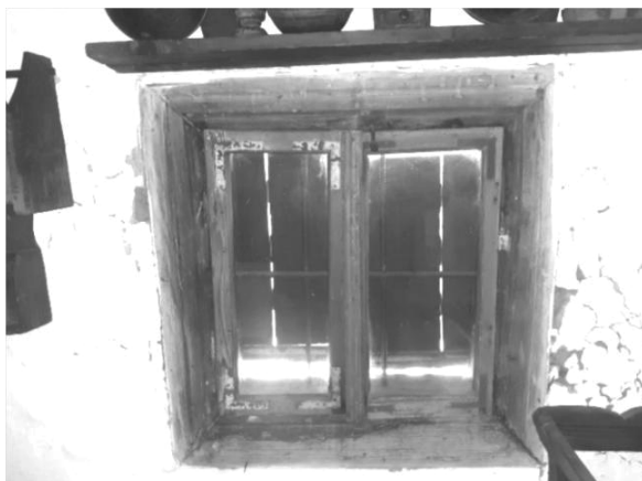
Fig. 130: Detaliu tâmplărie fereastră cu oblon exterior din încăperea C1.P.05.
