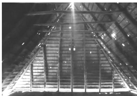
Fig. 139: Perspectiva interioară a structurii de tip fermă din podul clădirii. Sursă fotografie: arhitect Cantoni Nicholas (2022).
