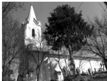
Fig. 154: Perspectivă ascendentă către biserica parohială din piatră a satului.
