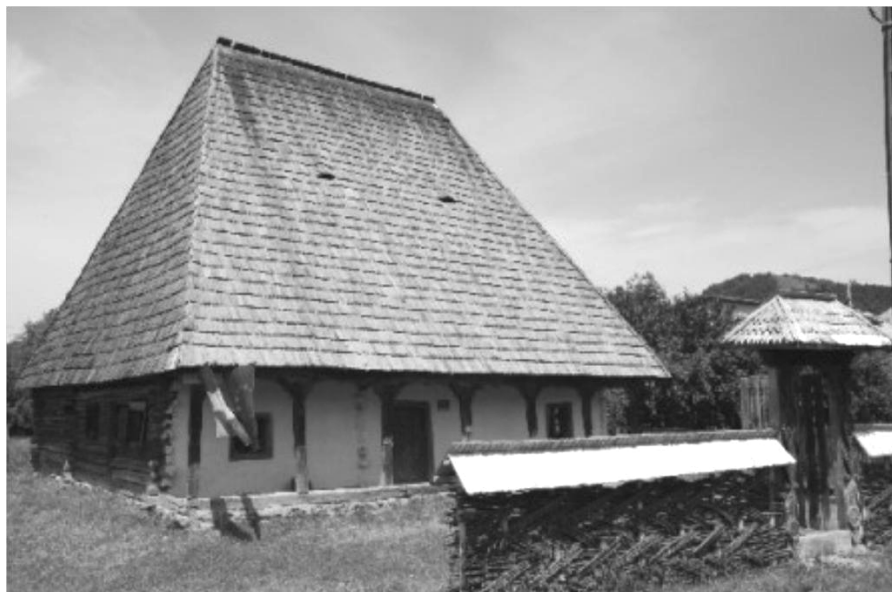
Fig. 68: Fotografie cu perspectiva exterioară din față a clădirii monument a fostei școli confesionale greco-catolice din Bârsana înaintea restaurării dintre anii 2012-2013. Sursă fotografie: muzeulmaramuresului.ro/descopera/conservari-in-situ/barsana-muzeul-scolar/ .
