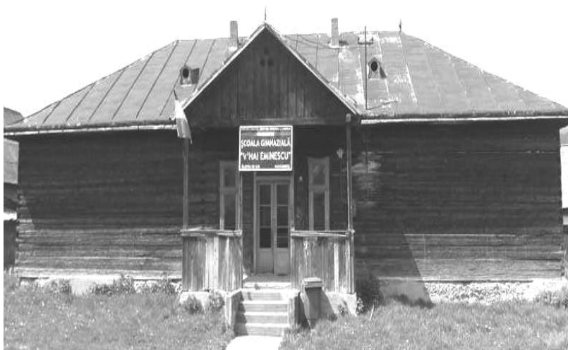
Fig. 53: Fotografie cu perspectiva exterioară a clădirii școlii gimnaziale „Mihai Eminescu” din Săliștea de Sus. (Fosta școală confesională greco-catolică din Săliștea de Sus).
