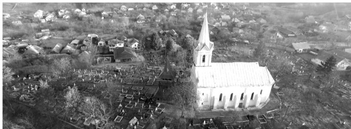
Fig. 150: Perspectiva aeriană a centrului satului Bârsana: dealul pe care se află cimitirul, biserica parohială din piatră „Sfinții Mihail și Gavriil” și capela exterioară din lemn a bisericii parohiale.
