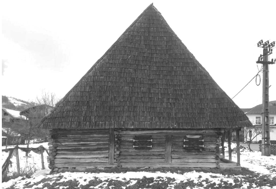
Fig. 71: Fotografie actuală (2022) cu fațada laterală (de sud) a clădirii fostei școli confesionale greco-catolice din Bârsana. Sursă fotografie: arhitect Cantoni Nicholas.
