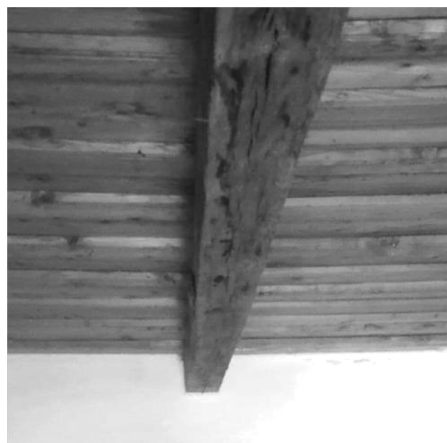
Fig. 98: Fotografie cu detaliul din câmp al tavanului încăperii P.02. dintre grinda structurală și scândurile dispuse în două rânduri ale închiderii tavanului casei.
