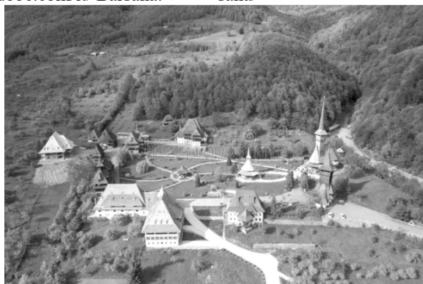
Fig. 155: Perspectiva aeriană a complexului mănăstirii ortodoxe de maici de la ieșirea din satul Bârsana. Sursă fotografie: https://manastireabarsana.ro/wp/
