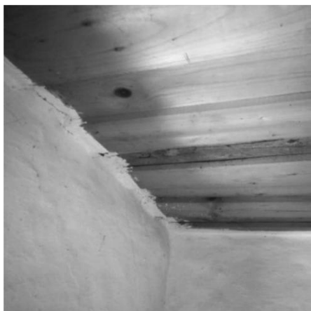
Fig. 97: Fotografie cu detaliul de colț al tavanului încăperii P.02 dintre perete și scândurile dispuse intercalat în două rânduri ale tavanului.
