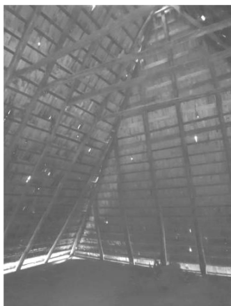
Fig. 143: Perspectivă interioară a șarpantei acoperișului din încăperea C1.P.07.
