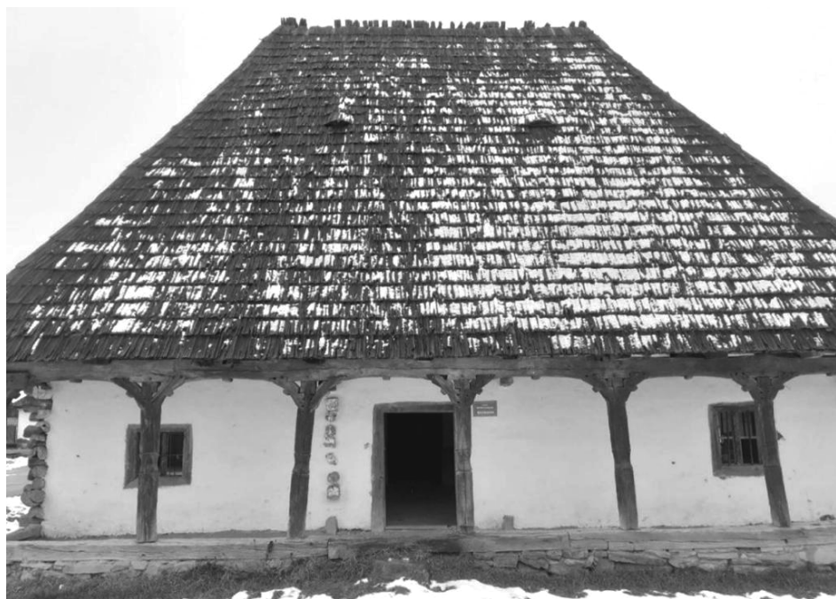
Fig. 70: Fotografie actuală (2022) cu fațada principală (de est) a clădirii fostei școli confesionale greco-catolice din Bârsana. Sursă: arhitect Cantoni Nicholas.
