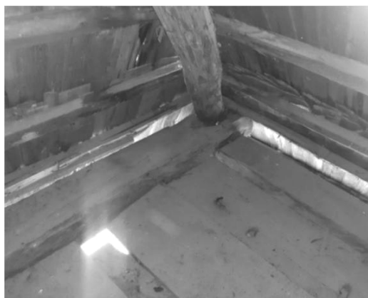
Fig. 141: Detaliu de colț al dușumelei în consolă a podului cu structura acoperișului.
