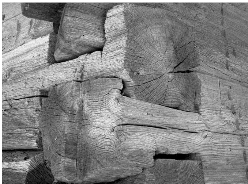
Fig. 51: Detaliu al chertării de colț al bârnelor de stejar care alcătuiesc pereții exteriori ai structurii bisericii monument UNESCO „Intrarea Maicii Domnului în Biserică”.
