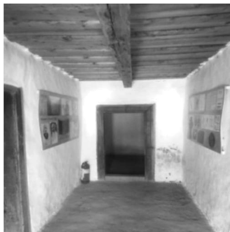
Fig. 95: Fotografie cu perspectiva interioară dinspre încăperea P.02 spre golul de acces către încăperea P.06. Sursă desen: arhitect Cantoni Nicholas.
