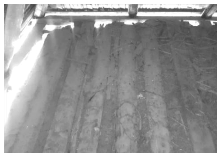
Fig. 140: Detaliu de dușumea de la nivelul podului clădirii de studiu. Sursă fotografie: arhitect Cantoni Nicholas (2022).
